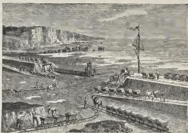
LE « DECAUVILLE » EST EMPLOYÉ PAR 2,200 ENTREPRENEURS DANS LE MONDÉ ENTIER. Il y a déjà 80 kilomètres et 4,750 wagons livrés, pour les terrassements à Paris.
